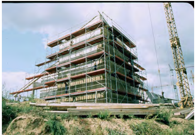
Gemeindezentrum im Bau
